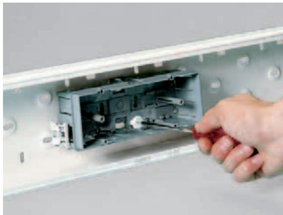
Il fissaggio della scatola porta apparecchi SAN-6 si effettua utilizzando l'elemento ZP1, che si ancora al fondo del canale sulla speciale imbutitura.
